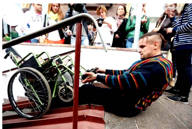
Рис. 6. Спуск по швеллерам с неприемлемым расстоянием между ними
