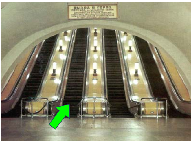
Рис. 15. Переход с одной линии метро на другую с лестницей, не доступной колясочникам (верхнее фото), и оборудованный эскалаторами (нижнее фото)
